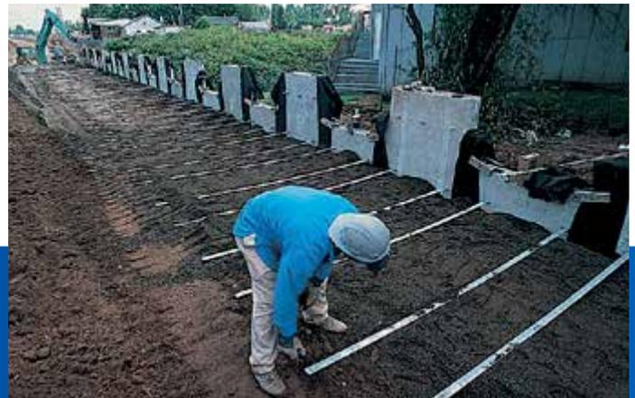
Las armaduras de refuerzo de alta adherencia (o **armaduras de acero de HA**) poseen recrecidos perpendiculares a su eje en ambas caras y un único taladro en un extremo para su conexión al paramento. Este es, con diferencia, el refuerzo de suelo Tierra Armada® más usado, con más de 40 millones de metros cuadrados de estructuras construidas en todo el mundo.
