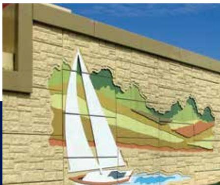
El aspecto de las escamas de hormigón prefabricadas puede mejorarse usando revestimientos arquitectónicos estándares o personalizados. También es posible lograr características estéticas adicionales mediante tratamientos específicos del hormigón como el tintado o la inclusión de agregados visibles.
