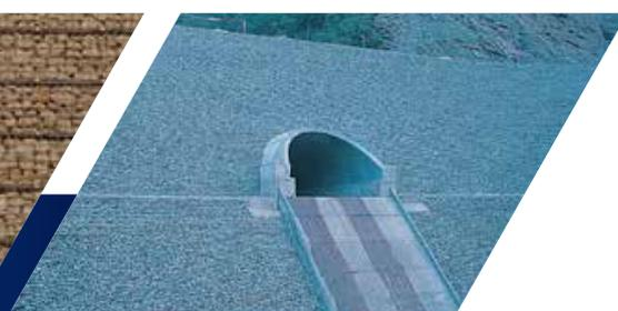
Paramento de malla de cable inclinado
